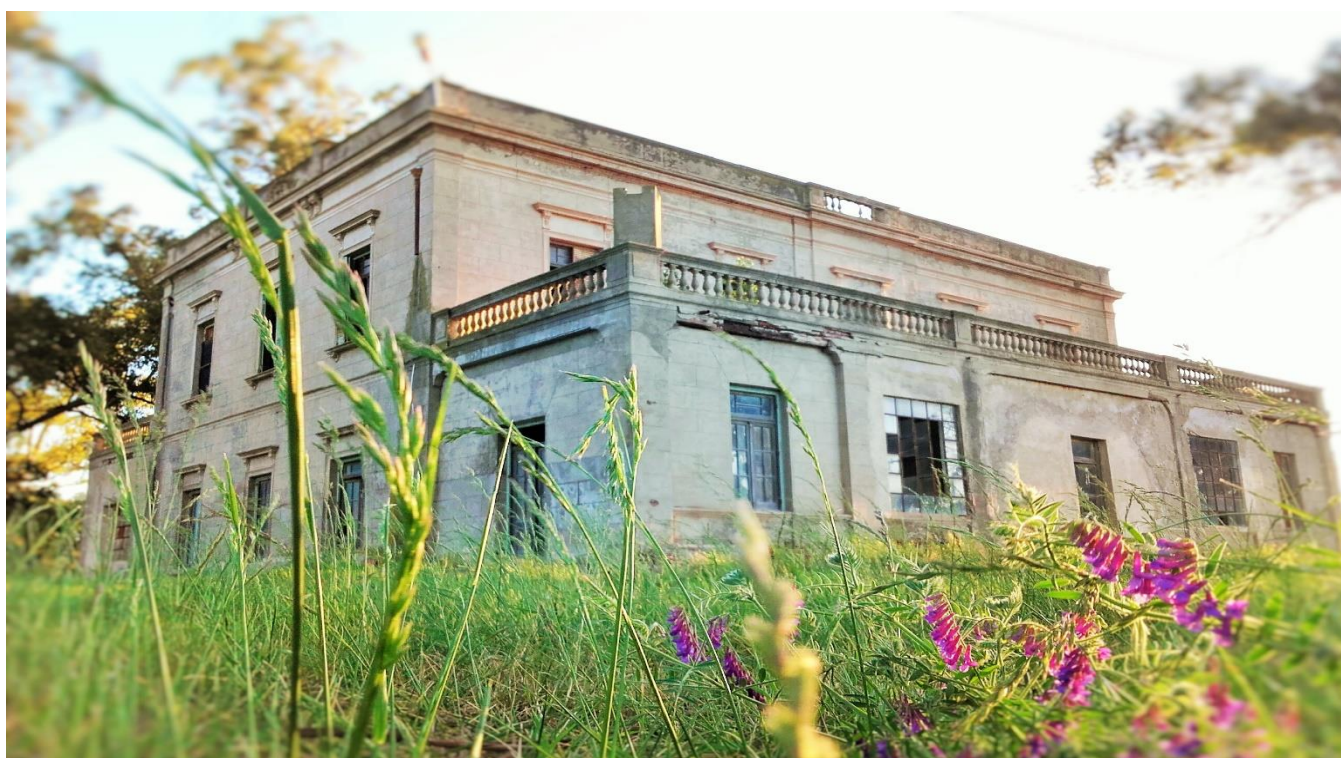
Estado actual de La Casona
